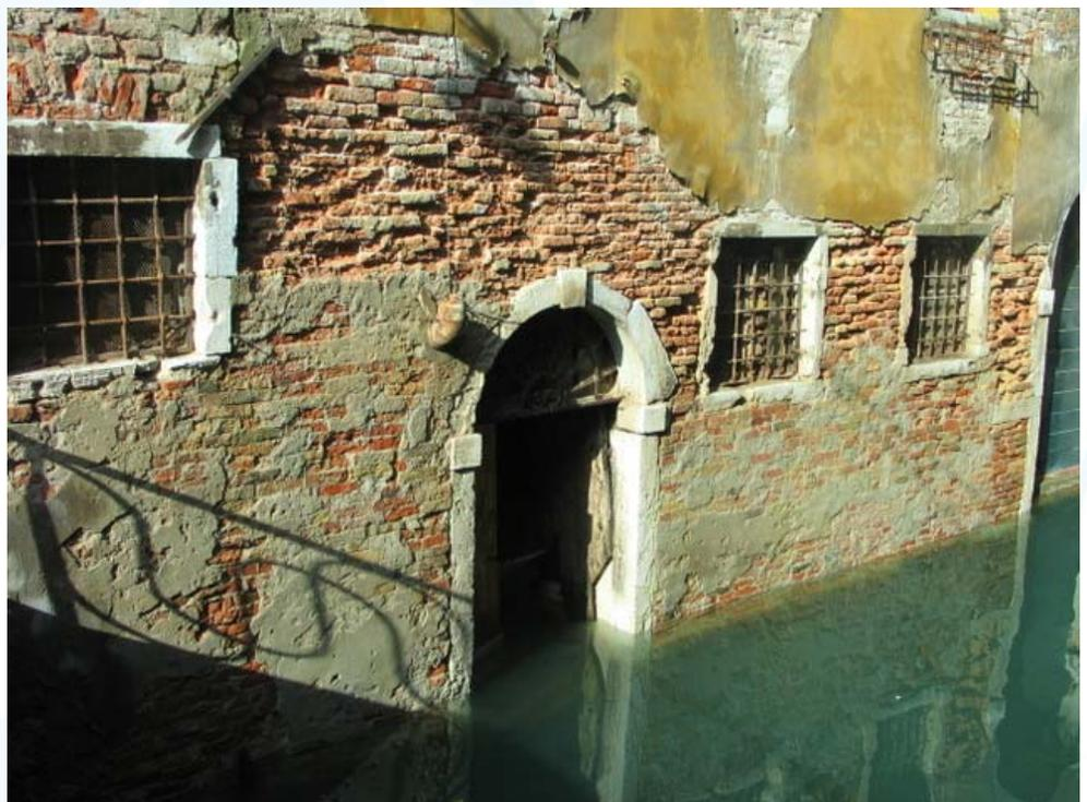
Effetti delle infiltrazioni sulle strutture murarie e conseguente stato di abbandono.
