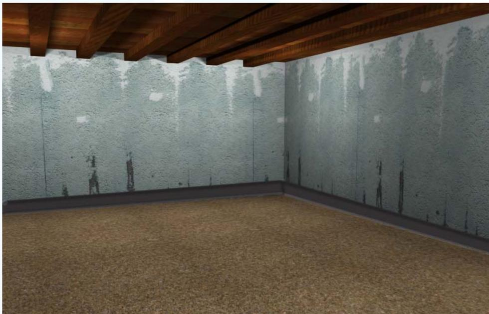
Il piano terra viene sgomberato, il pavimento e il terreno sottostante vengono rimossi.
